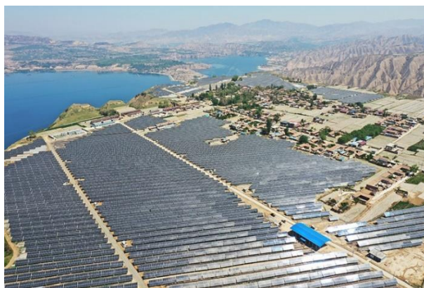
图 2-3 甘肃东乡县考勒乡坡根村“农光互补”光伏发电项目 29
