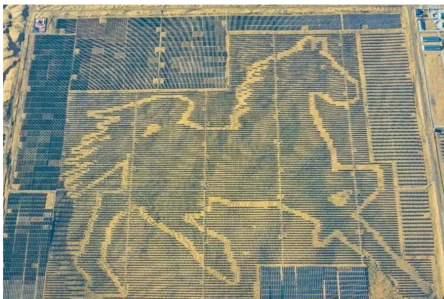
图 2-4 内蒙古自治区库布齐沙漠中的“骏马”光伏电站
