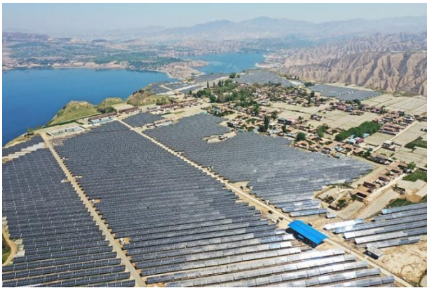
图 2-2 甘肃东乡县考勒乡坡根村“农光互补”光伏发电项目 28
