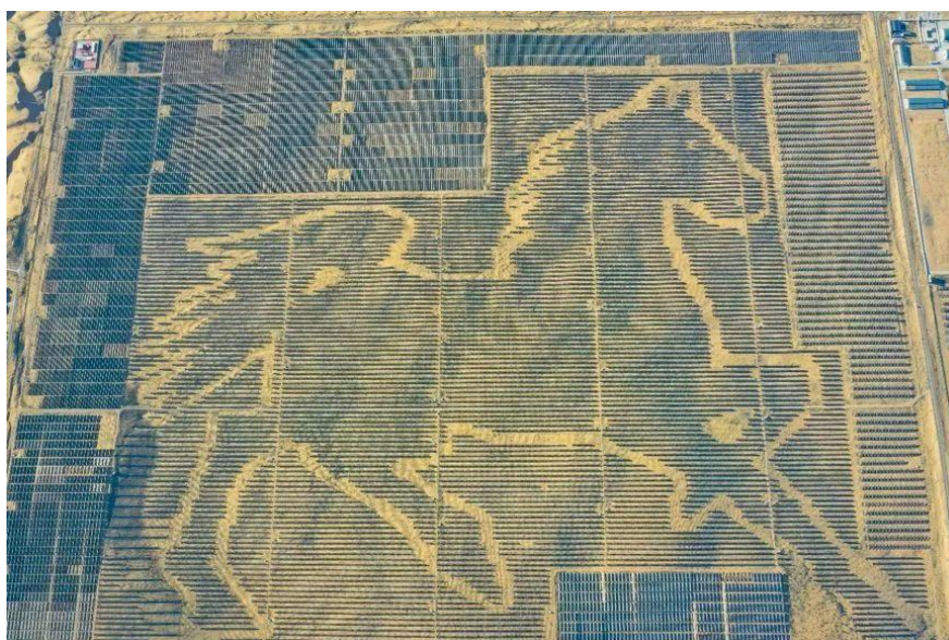
图 2-3 内蒙古自治区库布齐沙漠中的“骏马”光伏电站
